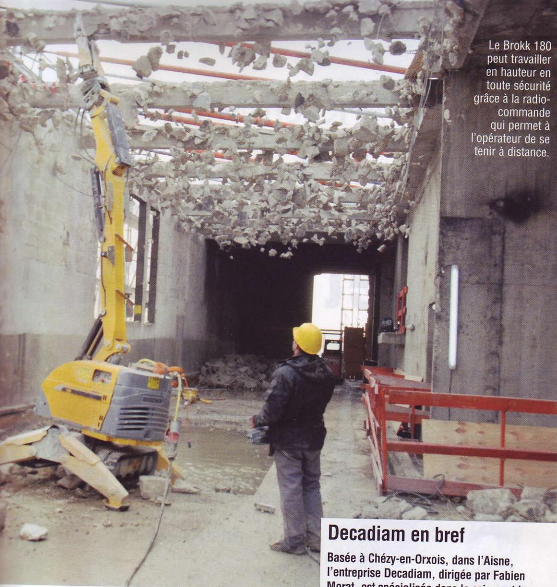
Le Brokk 180 peut travailler en hauteur en toute sécurité grâce à la radio-commande qui permet à l'opérateur de se tenir à distance.
