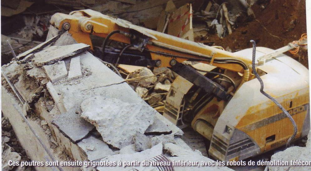
Ces poutres sont ensuite grignotées à partir du niveau inférieur, avec les robots de démolition télécommandés
