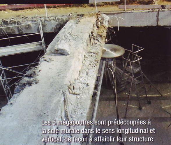
Les 5 mégapoutres sont prédécoupées à la scie murale dans le sens longitudinal et vertical, de façon à affaiblir leur structure
