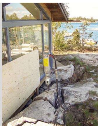
Démolition roche & pierre naturelle
