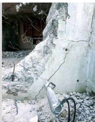
Démolition béton et béton armé
